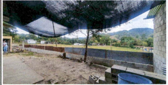
Foto 8: Patio y muro perimetral
