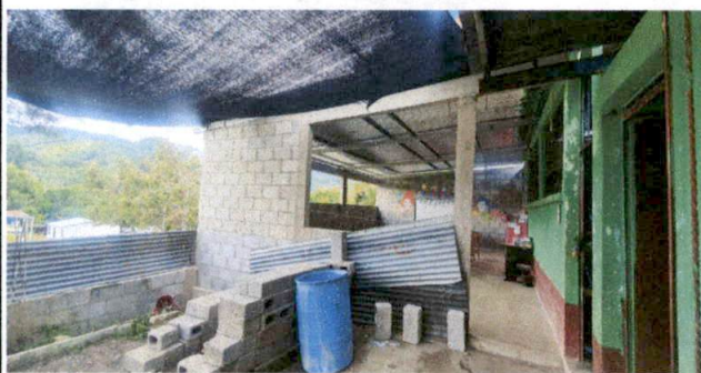
Foto 5: Modulo de aulas
